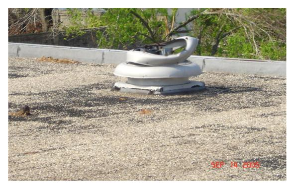
Damaged exhaust fan
